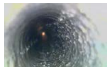
Intérieur d'une canalisation d'eau inspecté par endoscopie
