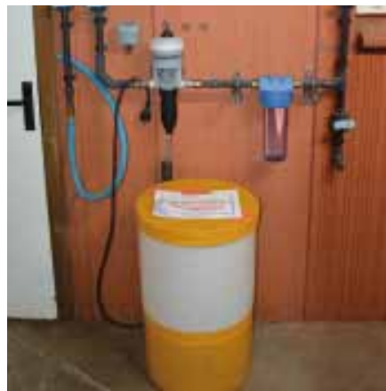
Dispositif d'administration d'antibiotique par pompe doseuse
