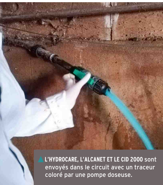
▲ LE FLUSHPIPE envoie des successions d'air et d'eau sous pression dans le circuit.
