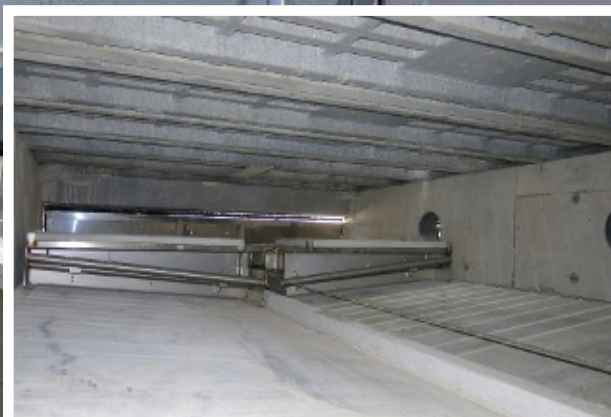
La fraction solide est évacuée en bout de bâtiment dans des conteneurs à l'aide des quatre rangées de racleurs en V Trac utilisées pour la salle de 144 places. ©Ifip
