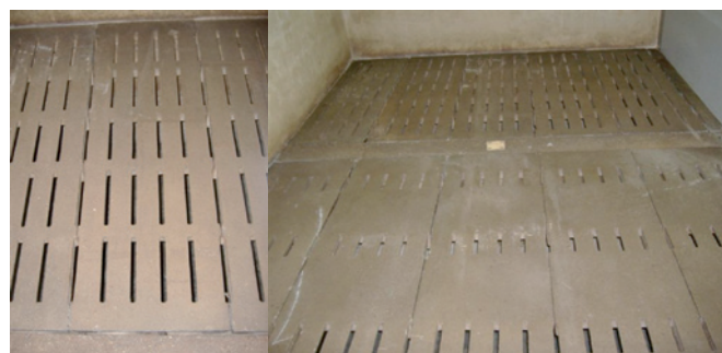
Photo 1 : Caillebotis à 15 % de vide (photo de gauche) sol mixte : gisoir drainant à 5 % sur les deux tiers avant et caillebotis à 15 % sur le tiers du fond de case (photo de droite)
