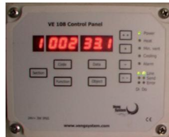
au boîtier de régulation de la salle disposé dans le couloir du bâtiment. En fonction du nombre de jours de présence des animaux et de la courbe de chauffage, le boîtier actionne le système de vérins permettant l'inclinaison du couvercle.
