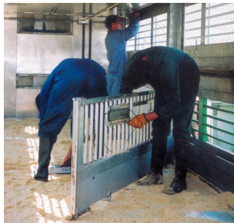
Photo 1 : Installation des appareils de mesure d'ambiance (T°C, humidité, taux de CO 2 , vitesse d'air au niveau des porcs dans un camion à 3 niveaux)
