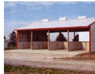
Silos de compostage en dur
