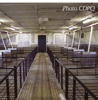
Dalot : caniveau pour évacuation du lisier sous le caillebotis.
